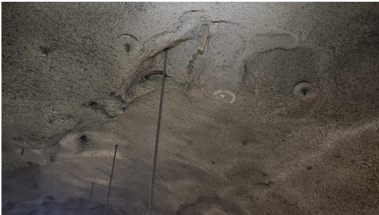
Foto 6. Pel 440. Tidligere merket bolt. Må boltes med 1 stk. 2,4 m bolt.
