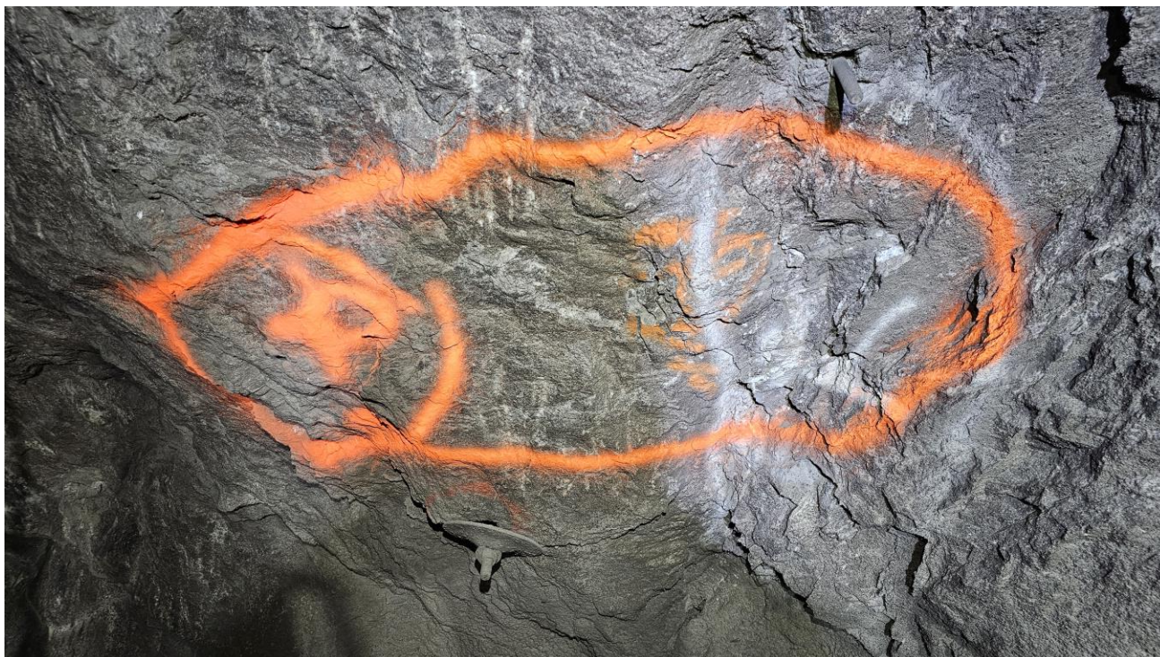
Foto 9. Pel 990. Småfallent og bomt berg. Må renskes og påføres sprøytebetong.
