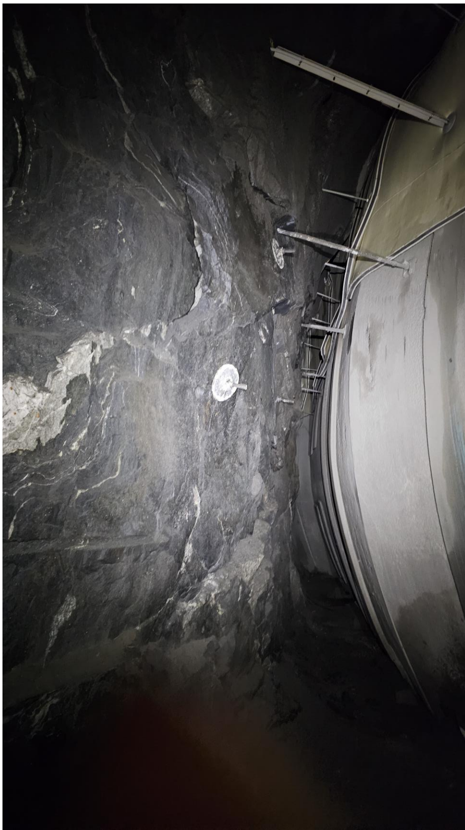
Foto 11. Pel 1760 v. side bak hvelv. Eksempel på korrosjon på bolter.
