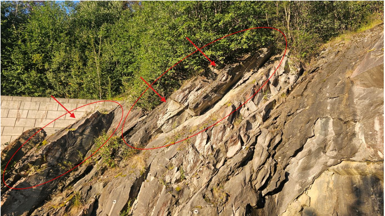
Foto 3. Forskjæring nord. Avløste blokker er markert med røde sirkler. Boltes med 3 stk. 3 meter lange bolter i retning vist på bildet.
