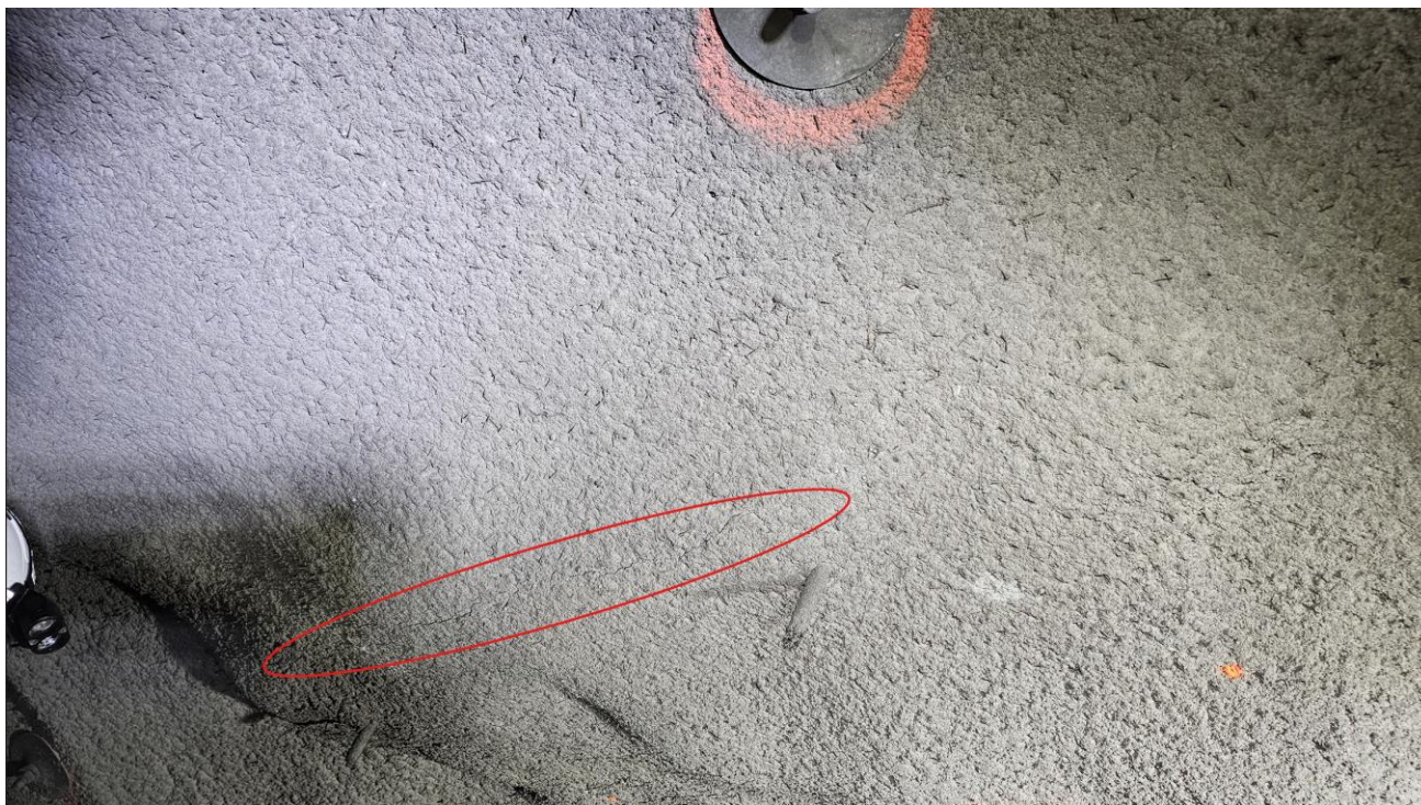
Foto 7. Pel 445. Oppsprekking i sprøytebetong, markert med rød ellipse. Følges opp ved neste inspeksjon for eventuell utvikling.
