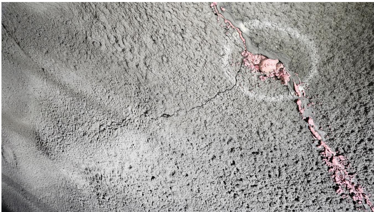
Foto 5. Pel 155. Langsgående riss i sprøytebetong for brannsikring.
