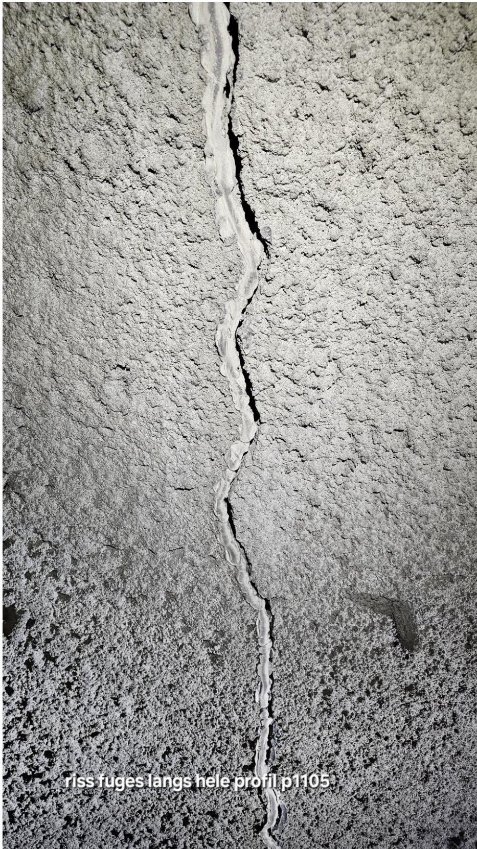
Foto 10. Pel 1105. Riss/sprekk i sprøytebetong for brannsikring. Må fuges.
