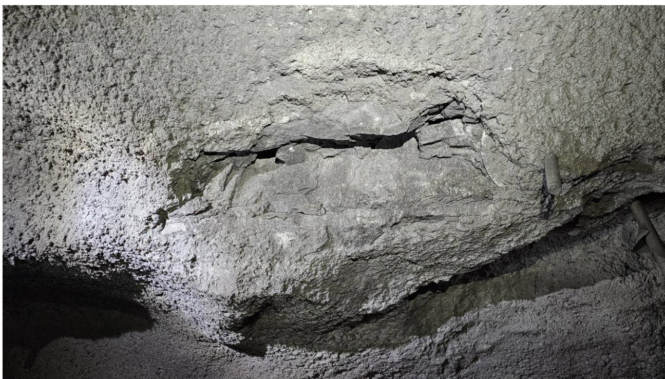
Foto 8. Pel 558. Hull i sprøytebetong. Tiltak ble anbefalt under forrige hovedinspeksjon og ikke utført. Må renskes og påføres ny sprøytebetong.
